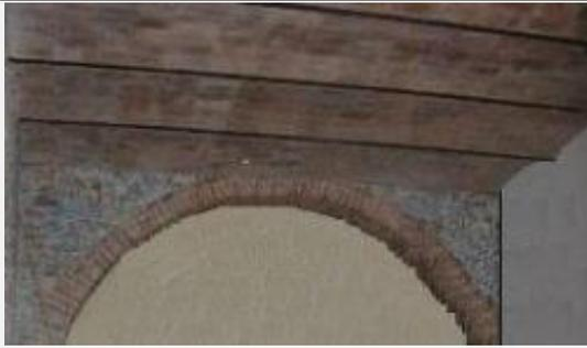
Esempio di solai con travi in ferro e voltine di mattoni
