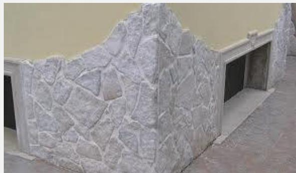
Esempi di rivestimenti in lastre applicati alla muratura per i quali non viene riconosciuto l'incremento.
